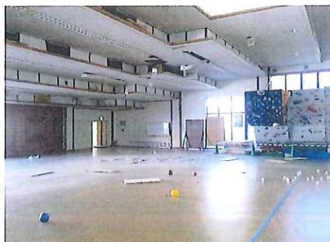
いたるところに亀裂が生じている （ケアハウス津南）
