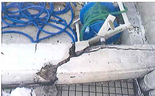
いたるところに亀裂が生じている （ケアハウス津南）
