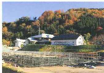
基礎工事中(H27.11撮影) 奥の建物は津南観光物産館、クアハウス津南
